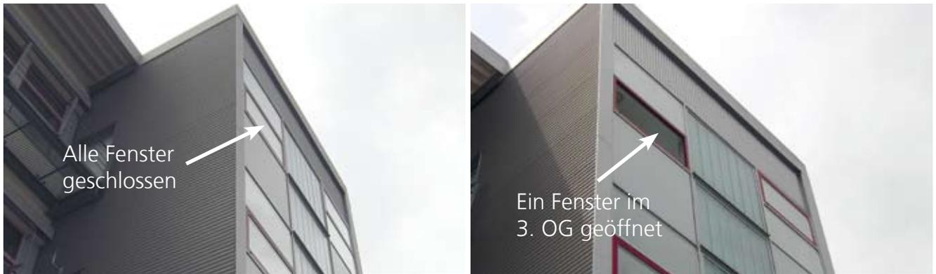
**links:** Außenansicht des Treppenraumes mit geschlossenem Lüftungsfenster **rechts:** Außenansicht des Treppenraumes mit geöffnetem Lüftungsfenster. Die Öffnungsfläche beträgt zirka 1,25 Quadratmeter.
