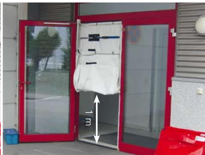
**links:** Zuluftöffnung im Erdgeschoss mit einem eingesetzten Mobil Rauchverschluss; lichte effektive Höhe der Zuluftöffnung zirka 1,5 Meter. Das herunterhängende Tuch wird hierzu hochgeschlagen und über die Spannstange gehängt. **rechts:** Zuluftöffnung im Erdgeschoss mit zwei eingesetzten Mobil Rauchverschlüssen; lichte effektive Höhe der Zuluftöffnung zirka ein Meter. Das herunterhängende Tuch wird hierzu hochgeschlagen und über die Spannstange gehängt.
