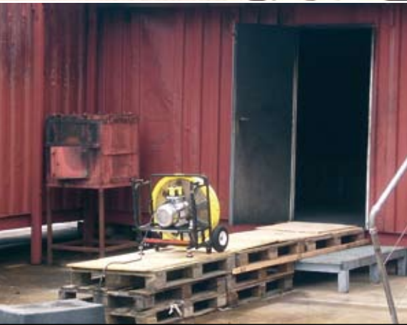
oben: Eingangssituation mit Zuluftöffnung im EG am Brandübungshaus der LFS unten: Eingangssituation mit Zuluftöffnung am Brandübungscontainer bei IFRT
